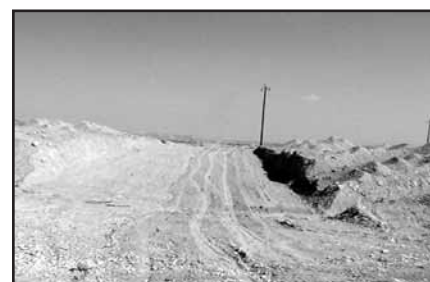
نگاره‌ی ۱۳ - مسیر انتقال گاز از منطقه و نقش تخریبی آن
