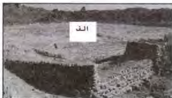
شکل (۲) نمونه‌ای از سرریز و زمین کشاورزی (الف)، نمونه‌ای از بند خشکه چین و دریچه‌ی تخلیه (گر) در خوشاب‌ها (ب)
