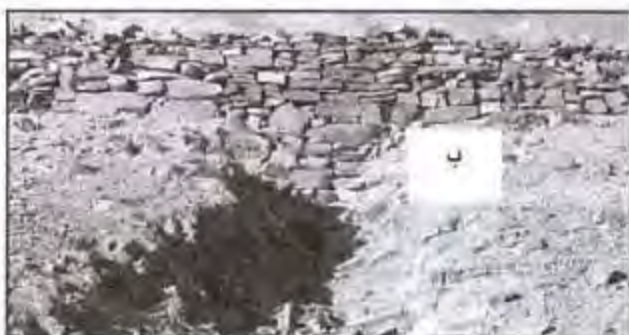
شکل (۲) نمونه‌ای از سرریز و زمین کشاورزی (الف)، نمونه‌ای از بند خشکه چین و دریچه‌ی تخلیه (گر) در خوشاب‌ها (ب)
