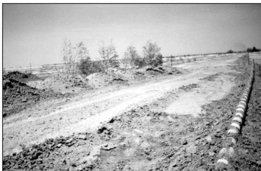
شکل ۱: نحوه اجرای روش آبیاری زیرسطحی از طریق نصب لوله های سفالی رانشان می دهد
