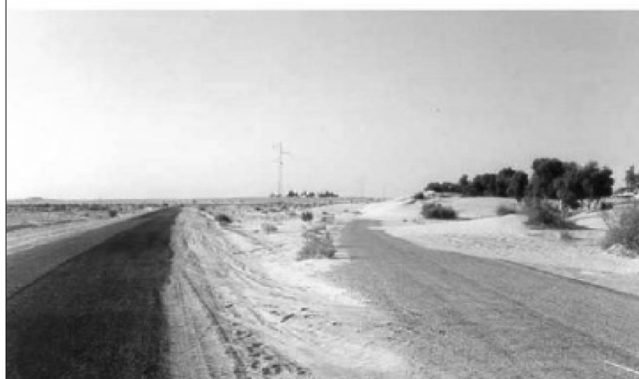
شکل ۸: رسوبات پشت یک بادشکن در سه سال متوالی در جنوب تونس جهت جریان باد از سمت راست به چپ بوده است.
