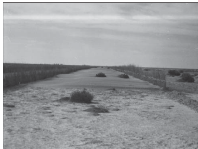
شکل ۲- پروژه احداث بادشکن غیرزنده در بستر دریاچه هامون
