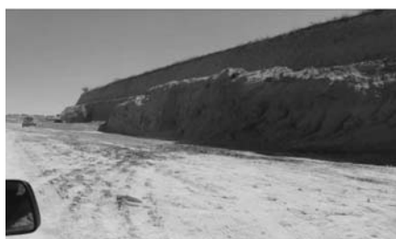
شکل ۱۰- تخریب خاک‌های لسی در گردنه بدرانلو در اثر عملیات راهسازی
