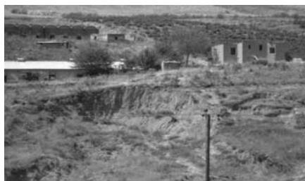
شکل ۸- خط انتقال برق و احداث مرغداری در دامنه لسی لغزشی در منطقه بدرانلو
