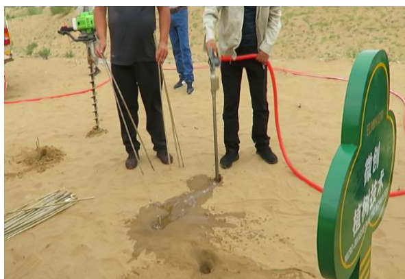
شکل ۱-۵۳- نمایی از کاشت قلمه با فشار کم جت آب و نحوه اجرای آن
