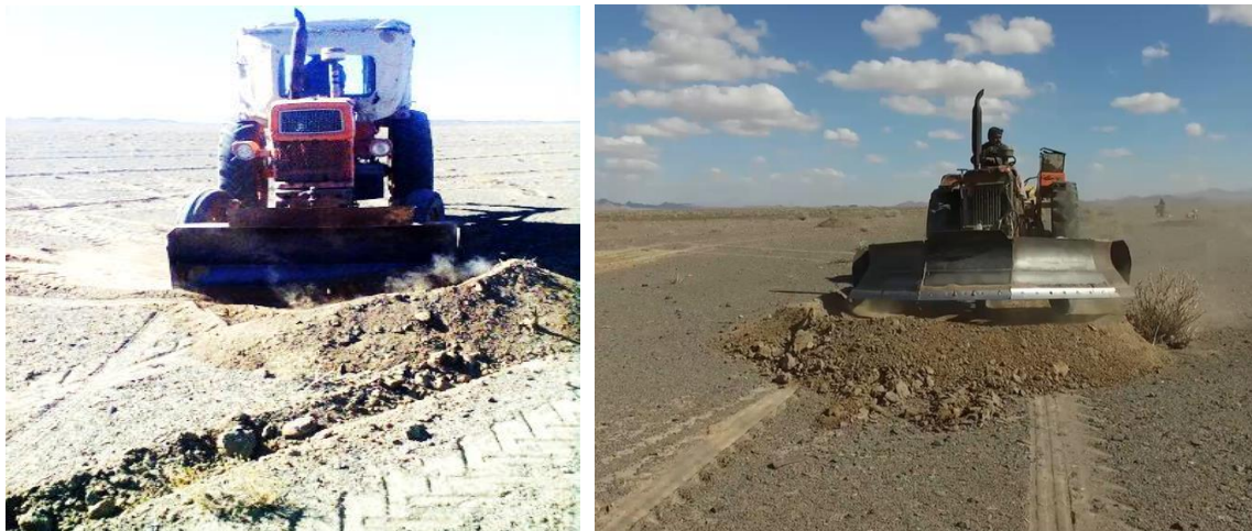
شکل ۲-۷- مراحل احداث هلالی آبگیر با تراکتور
