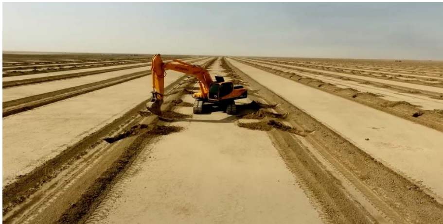
شکل ۱-۹- نمایی از حفر چاله کشت گیاه با استفاده از بیل مکانیکی
