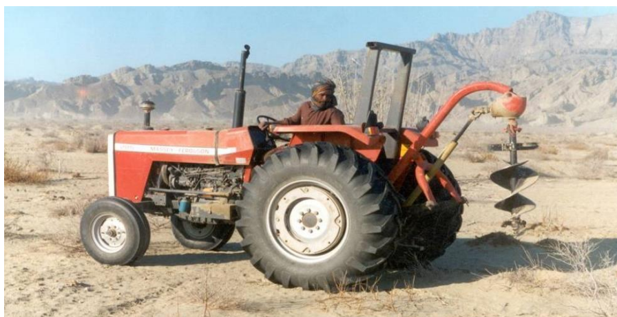
شکل ۱-۸- نمایی از حفر چاله کشت گیاه با استفاده از مته‌های مارپیچ
